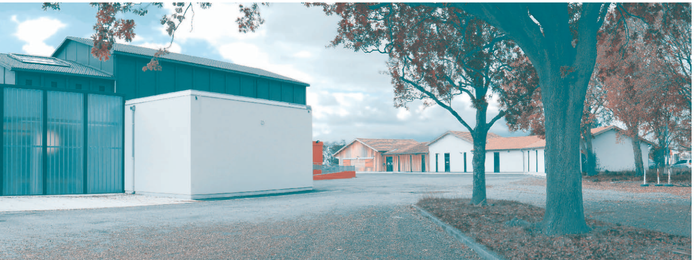
Le Bel Ordinaire entièrement rénové. À gauche : les ateliers de création. Au centre : les espaces d'exposition. À droite : les bureaux et les hébergements pour les artistes.
